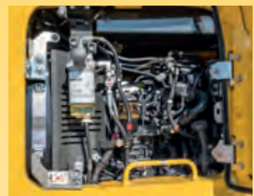
Zentral angeordnete Filter
